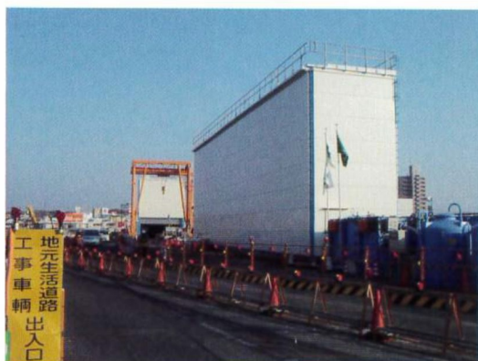
⑨ 道路占有に設置された仮設プラント
