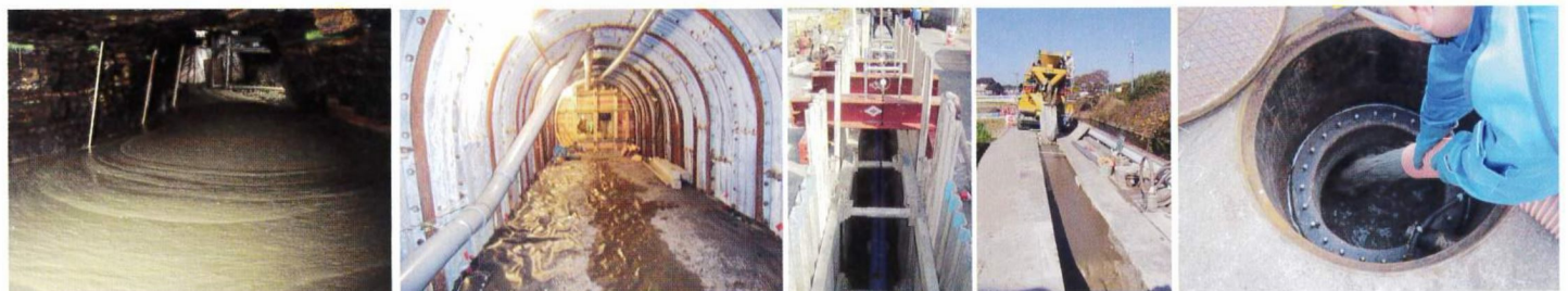
⑬ 亜炭廃坑埋戻試験 ⑭ 地滑り帯排水トンネル閉塞 ⑮ 国交省社会実験下水管 ⑯ 都市インフラ廃止管閉塞
