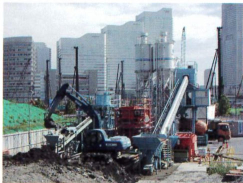
① 大規模仮設プラント
