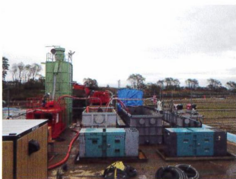
⑥ 中規模仮設プラント
