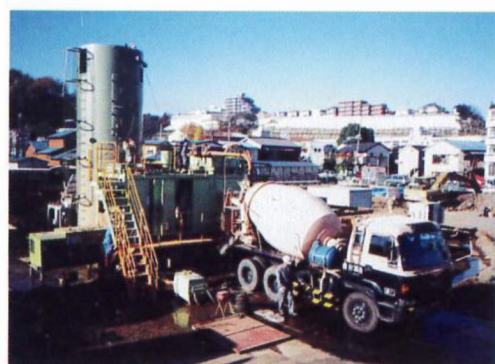
⑦ 市街地中規模仮設プラント
