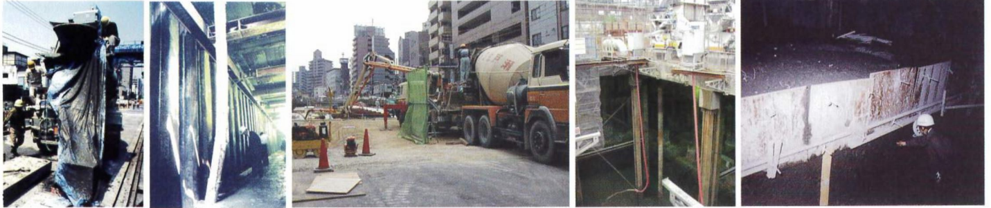
① 共同溝直投へのホッパー打設 ② 共同溝ポンプ圧送打設 ③ 大深度へのシュート打設 ④ 養生3日でのリフト打設
